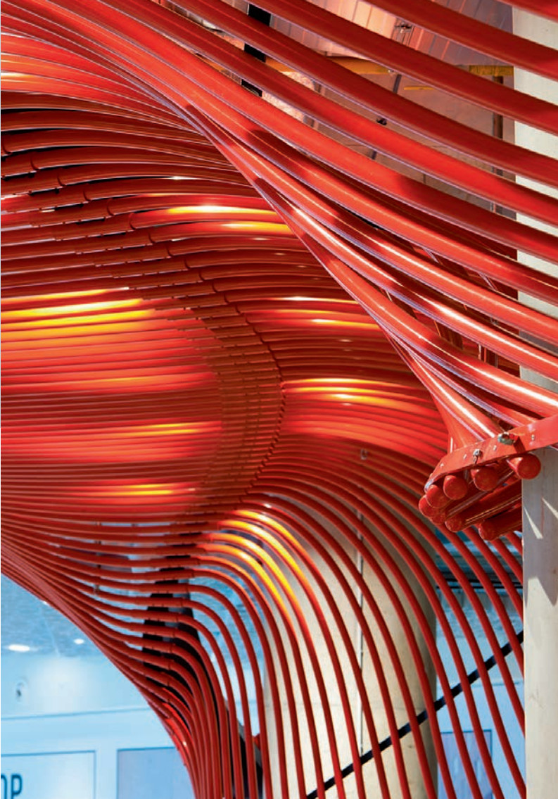
Die 466 Aluminiumrohre sind 3D-Freiform gebogen. Les 466 tubes en aluminium sont courbés dans une forme libre 3D.
